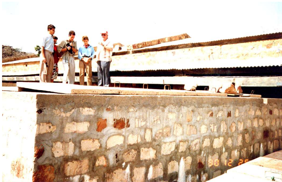
Visite des travaux de construction d'une citerne.
