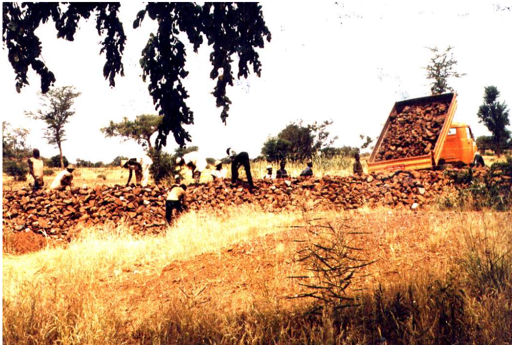
Construction d'une digue au Burkina Faso.
