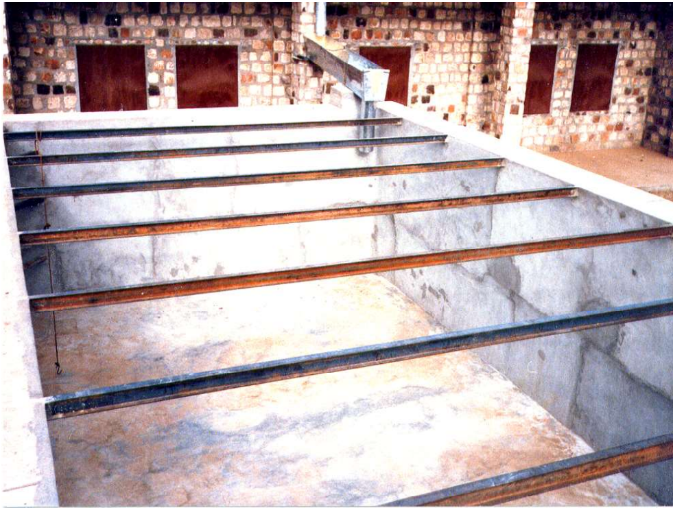
Citerne en attente du revêtement d'étanchéité.
