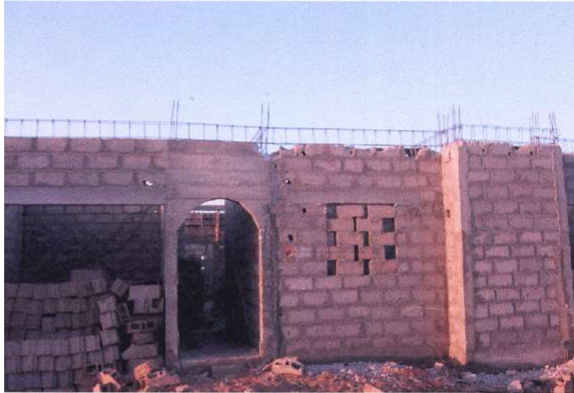
Avant le coulage du chaînage
