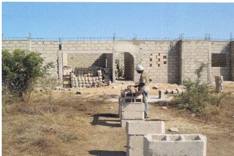
Après coulage du chaînage et en attente du dallage
